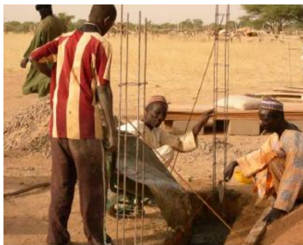
Coulée des fondations
